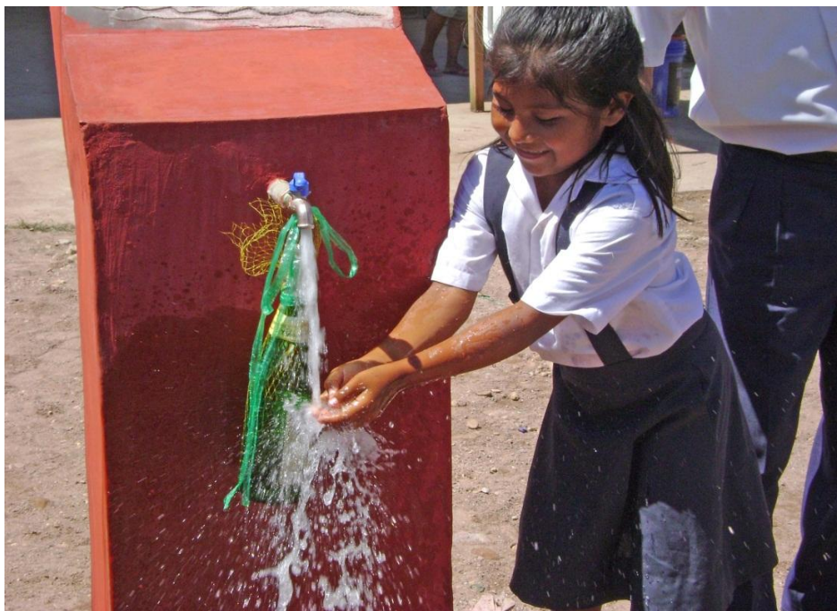
Pila Pública de agua potable en el área rural
